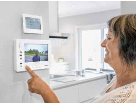
Bei der Haussteuerung wird moderne Sensortechnik wie Sonnensensor, Windsensor, Temperatursensor eingesetzt. Dazu kommen Sicherheitssensoren wie Rauchmelder, Öffnungsmelder (Tür- und Fensterüberwachung) und Außenbewegungsmelder.
